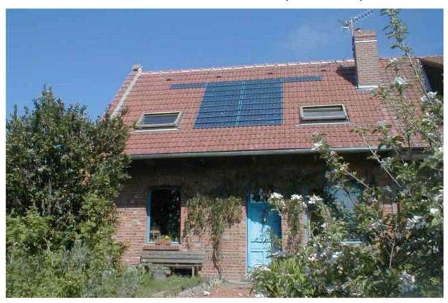
Sans pour autant viser énergétique, l'autonomie le propriétaire de cette maison individuelle souhaitait une double valorisation de l'énergie solaire : en électricité grâce à des « tuiles photovoltaïques » et en chaleur pour l'eau sanitaire grâce à des panneaux solaires thermiques.
