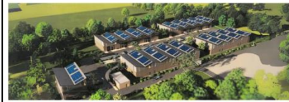
La centrale solaire est répartie sur les toits de cinq bâtiments.
