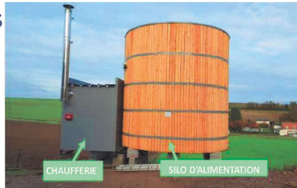
8 tonnes de stockage / 100 kW / 20 m<sup>2</sup> au sol
